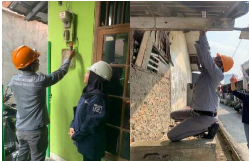
Figure 9. Perbaikan Instalasi Listrik Rumah
