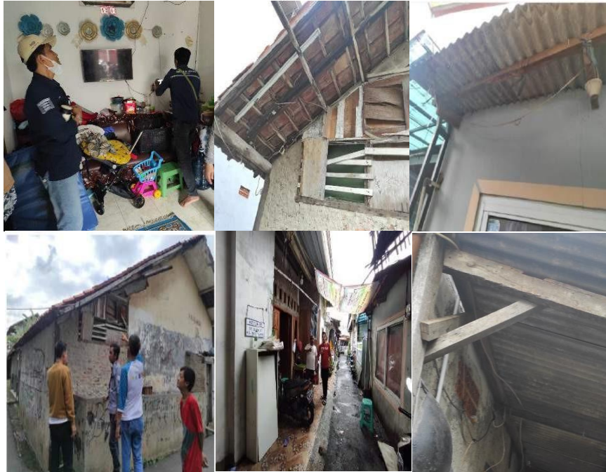
Figure 3. Foto Survey Instalasi Rumah
