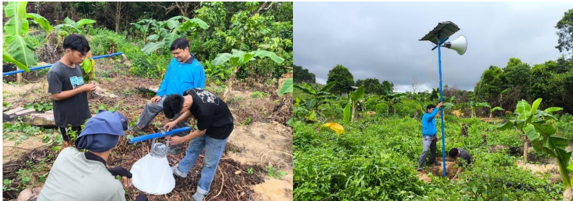
Figur 5. Pemasangan Alat Teknologi Pendeteksian dan Pengusir Monyet
