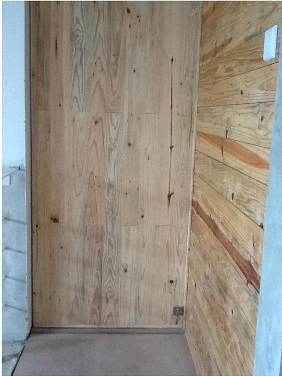
Setelah 1 (satu) bulan pemasangan, kayu palet yang digunakan tersebut mengalami penyusutan yang cukup berarti (0.3 – 0.7mm). Namun tidak semua susunan papan palet tersebut mengalami hal yang sama, hanya beberapa 1-2 lembar papan saja yang mengalami penyusutan. Hal ini bermakna, ada sebagian kecil papan kayu tersebut tidak mengalami proses pengeringan yang baik, sehingga kandungan air masih tertinggal dalam pori-pori kayu.
