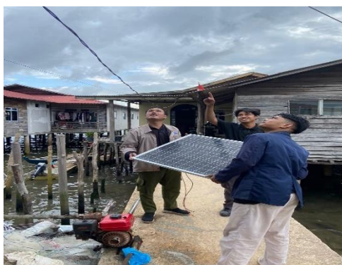
Gambar 4. Pemasangan solar cell
