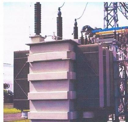
Gambar 9 Tranformator Daya pada GI
