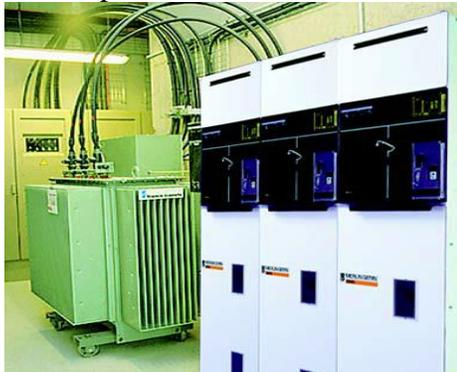
Gambar 3.5. Trasformator Daya Gardu Distribusi Kabil PLN Batam
