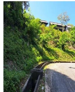
Saluran drainase berfungsi mengalirkan air hujan atau limpasan dari permukaan tanah ke tempat pembuangan yang aman, menjaga area sekitar resor tetap kering dan nyaman bagi pengunjung.
