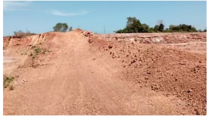
Gambar 6. Foto dokumentasi eksisting 5 (sumber: dokumen pribadi, 2025)
